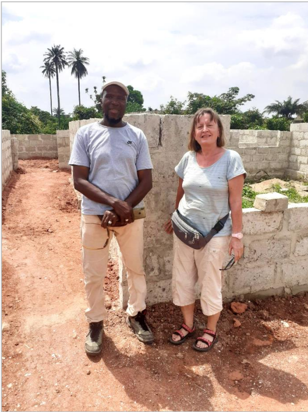
Musah Abubakar und Irmgard Kurz auf der Baustelle
