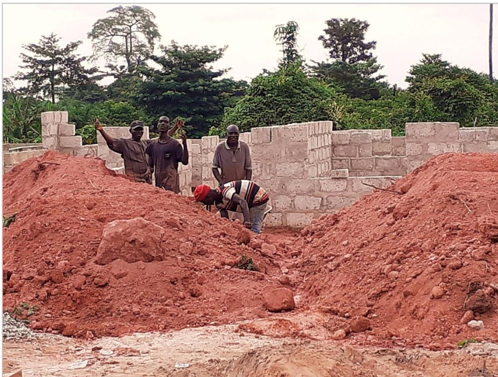
Hausbau allein durch „menpower“. Das Bauprojekt gibt den Familien vor Ort Arbeit
